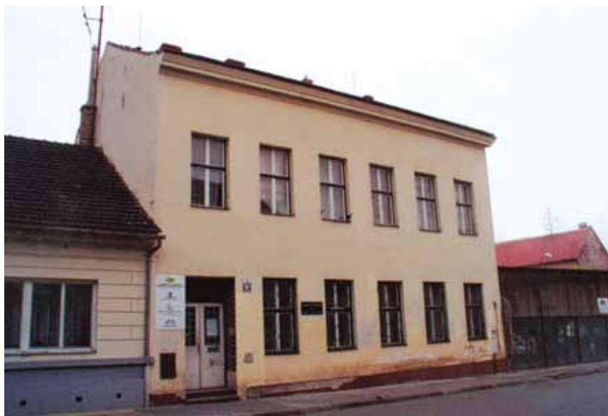
Budova Slezského muzea v Brně na Chaloupkově ulici
