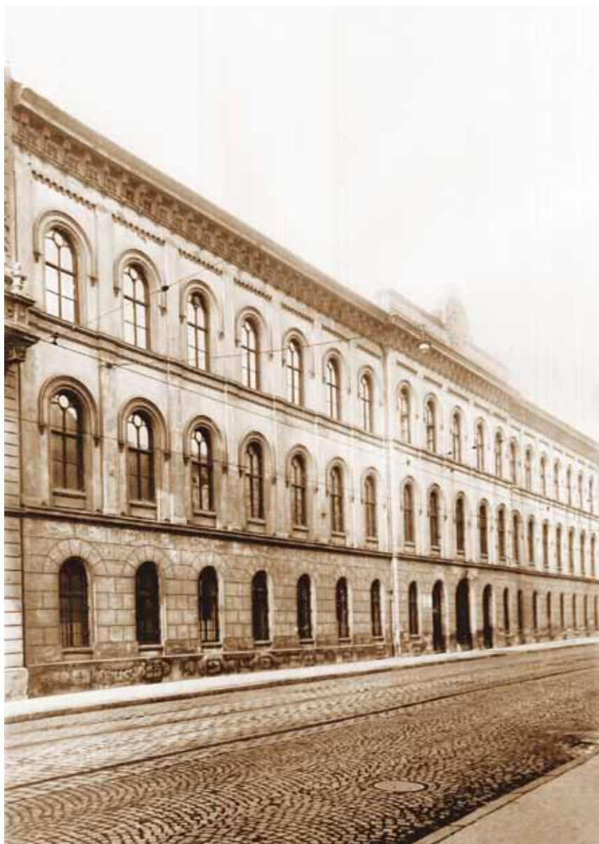
Budova ZDŠ pro nevidomé a slabozraké žáky v Brně na Veveří ulici
